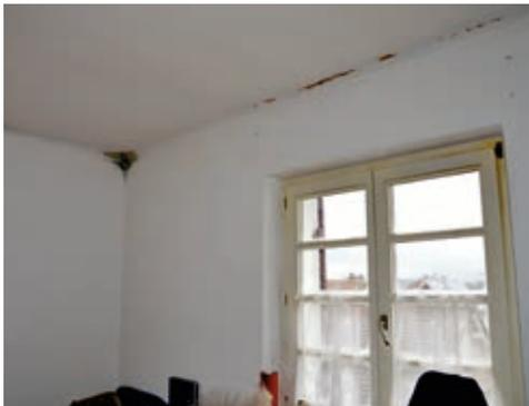
Abb. 3: Hohe Luftfeuchtigkeit führt zu Kondensat in den Raumecken und somit zu Schimmel
