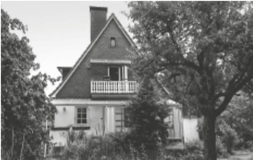
Abb. 2: Wohnhaus vor der Sanierung
